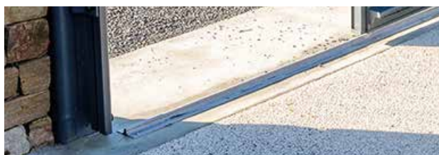
Rail inox de couissant en U antidéraillement
