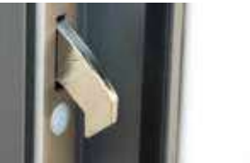
Serrure 3 points sur l'ouvrant principal.
