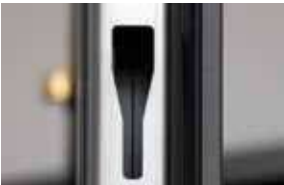
Serrure 3 points sur l'ouvrant principal.
