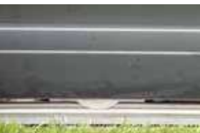
Crémaillère et roulette intégrées dans le portail coulissant
