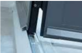
Jet d'eau filant en partie basse pour garder le garage au sec (ouverture intérieure).
