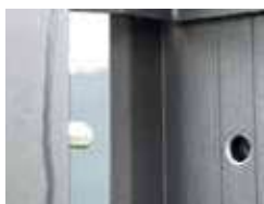
Doigt inox anti-soulèvement (portail coulissant)
